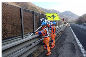
規制標識設置
