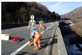
規制機材設置
